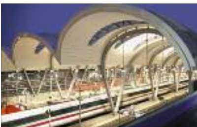
Für den Hauptbahnhof Kiel hat Zambelli das Bedachungssystem Rib-Roof geliefert und montiert
