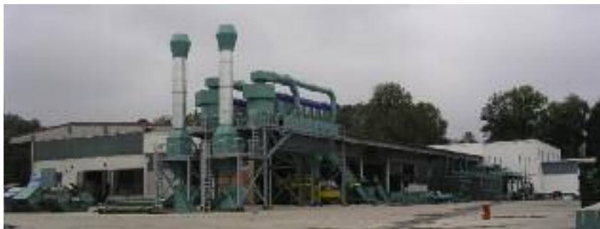
Gewerbemüllsortieranlage, Werk 5, Penning
